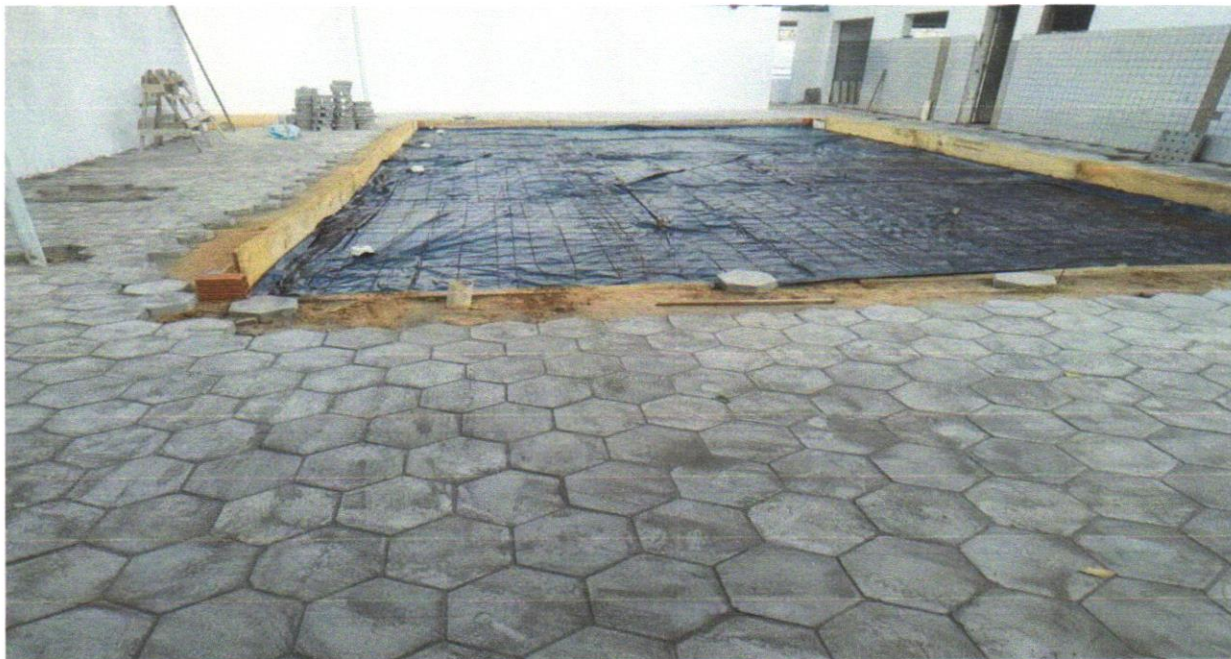
FOTO 14 - FORNECIMENTO E INSTALAÇÃO DE TELA AÇO SOLDADA NERVURADA CA-60, MALHA 15X15CM, FERRO 3.4MM, PAINEL 2X3M, (1,00KG/M²), MALHA POP MÉDIA GERDAU OU SIMILAR
