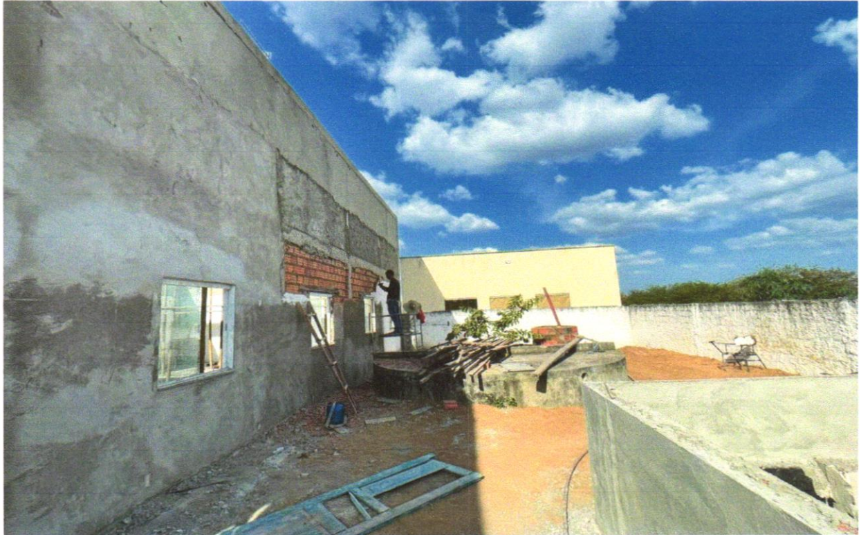
FOTO 05 - VERGA PRÉ-MOLDADA PARA JANELAS COM ATÉ 1,5 M DE VÃO E CONTRAVERGA PRÉ-MOLDADA.
