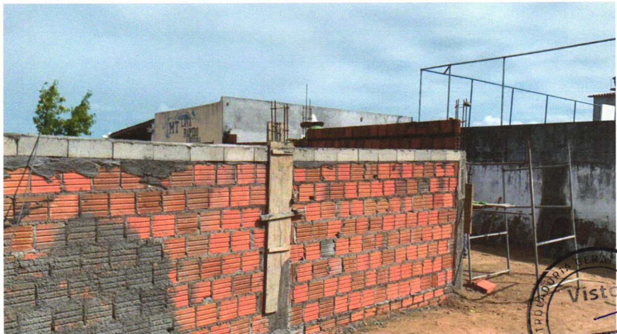
FOTO 04 - ALVENARIA DE VEDAÇÃO DE BLOCOS CERÂMICOS FURADOS NA HORIZONTAL DE 9X19X19CM
