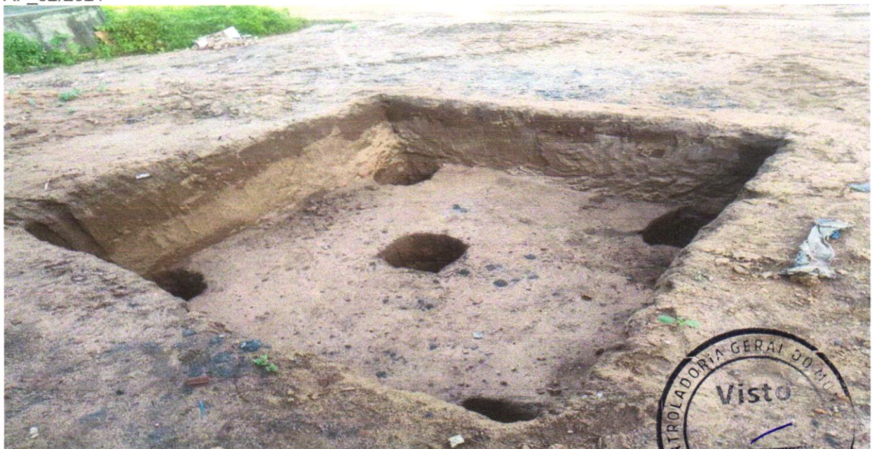
FOTO 26 - ESCAVAÇÃO MANUAL DE VALA COM PROFUNDIDADE MENOR OU IGUAL A 1,30 M. AF_02/2021
