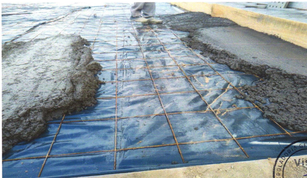
FOTO 14 - FORNECIMENTO E INSTALAÇÃO DE TELA AÇO SOLDADA NERVURADA CA-60, MALHA 15X15CM, FERRO 3.4MM, PAINEL 2X3M, (1,00KG/M²), MALHA POP MÉDIA GERDAU OU SIMILAR
