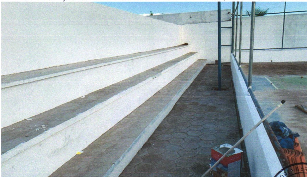
FOTO 24 - APLICAÇÃO DE FUNDO SELADOR ACRÍLICO EM PAREDES, UMA DEMÃO. AF_06/2014
