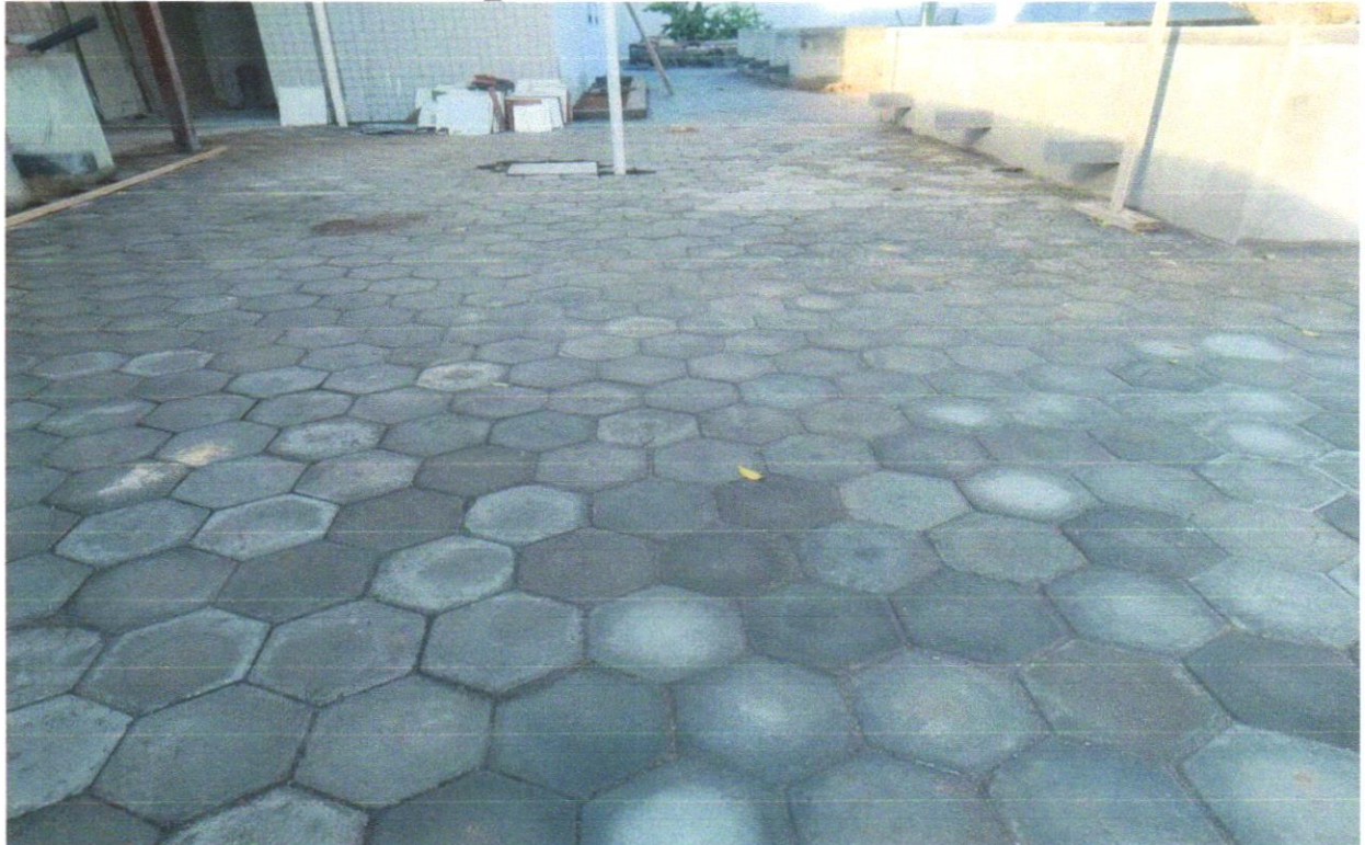
FOTO 17 - EXECUÇÃO DE PAVIMENTO EM PISO INTERTRAVADO, COM BLOCO SEXTAVADO DE 25 X 25 CM, ESPESSURA 8 CM. AF_12/2015
