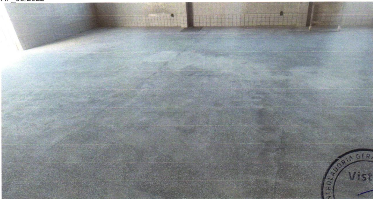
FOTO 16 - PISO EM GRANILITE, MARMORITE OU GRANITINA EM AMBIENTES INTERNOS, COM ESPESSURA DE 8 MM, INCLUSO MISTURA EM BETONEIRA, COLOCAÇÃO DAS JUNTAS, APLICAÇÃO DO PISO, 4 POLIMENTOS COM POLITRIZ, ESTUCAMENTO, SELADOR E CERA. AF_06/2022
