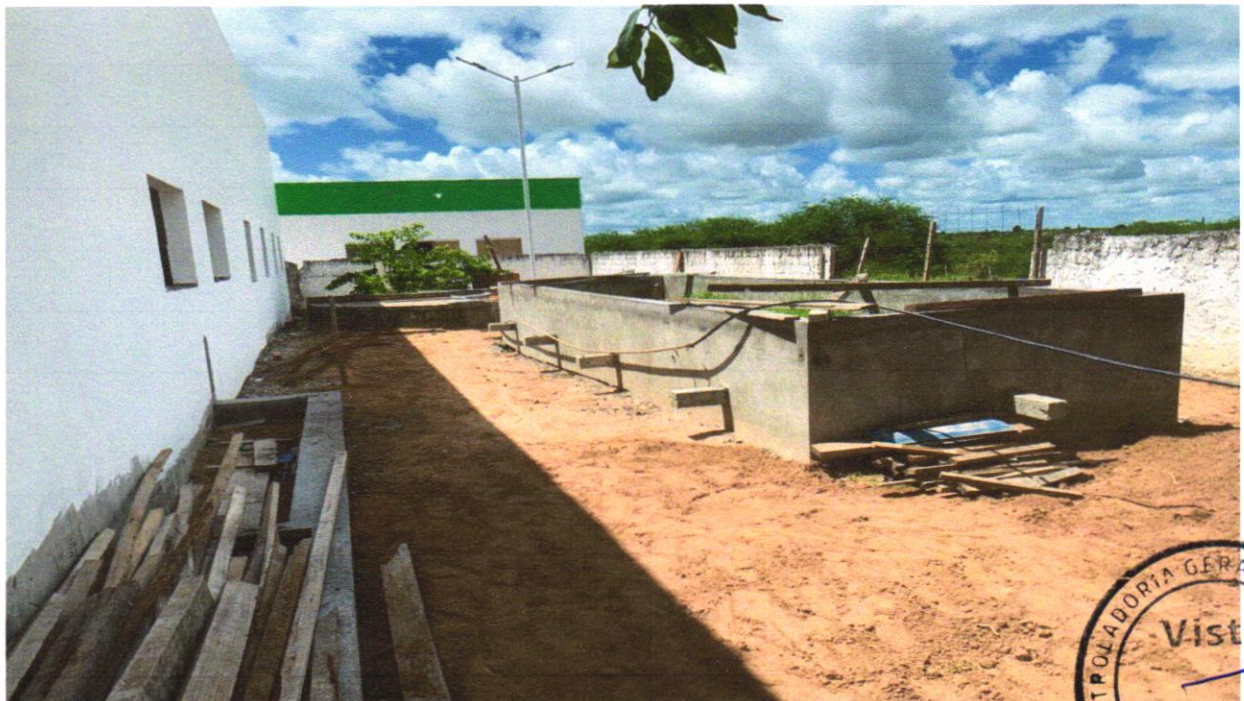
FOTO 02 - ATERRO MANUAL DE VALAS COM AREIA PARA ATERRO E COMPACTAÇÃO MECANIZADA
