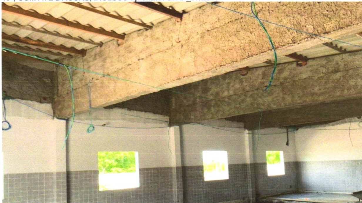
FOTO 19 - TELHAMENTO COM TELHA ONDULADA DE FIBROCIMENTO E = 6 MM, COM RECOBRIMENTO LATERAL DE 1 1/4 DE ONDA PARA TELHADO COM INCLINAÇÃO MÁXIMA DE 10°, COM ATÉ 2 ÁGUAS, INCLUSO IÇAMENTO. AF_07/2019
